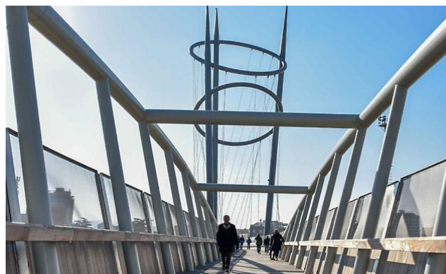
Percorso pedonale sopraelevato che collega il parcheggio alla stazione F.S. di Terni
